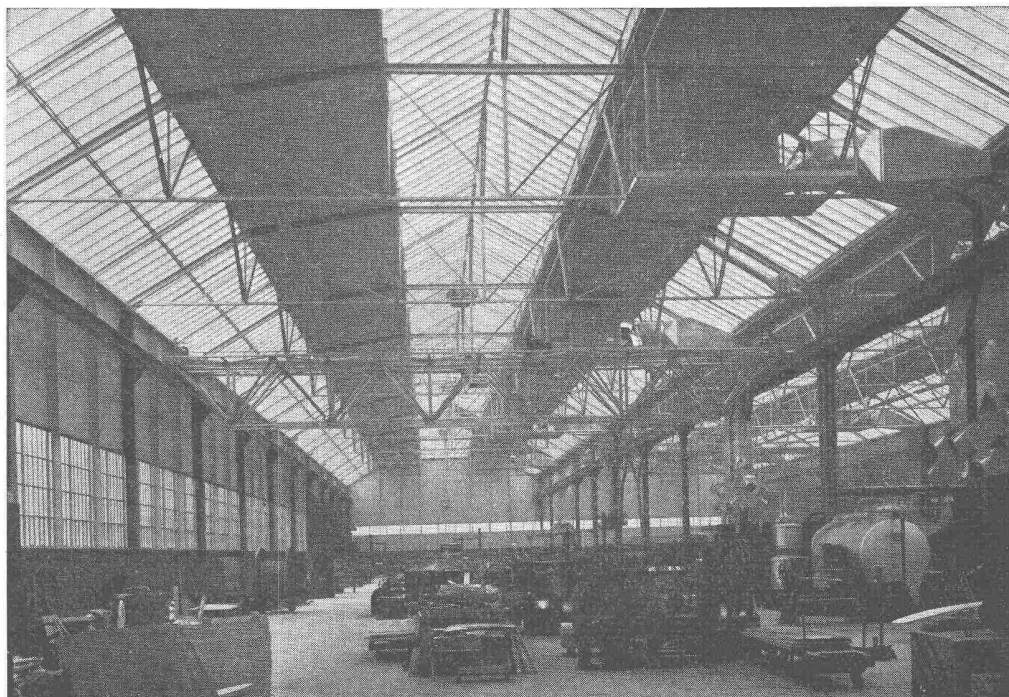
Produktionshalle, Krangerüst in Leichtmetall
