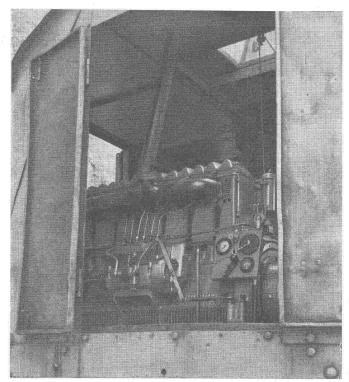
Bild 2. Raupenbagger mit lutgekühltem SLM-Dieselmotor
