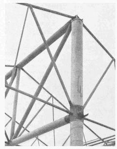
Bild 2. Anschluss des Längsunterzuges an die Säule
