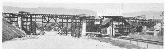
Bild 1. Lehrgerüst für Eisenbahn- und Strassenüberführung Studen-Biel
