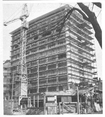
Bild 2. H-Rahmen-Fassadengerüst in Zürich
