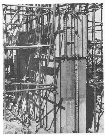
Bild 3. Wallform-Schalung als Brückenpfeiler-Kletterschalung bei der dritten Giessetappe
