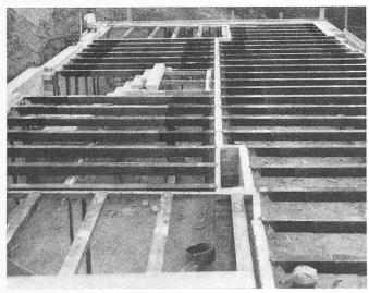
Bild 5. Teleskop-Schalungsträger aus Stahlblech
