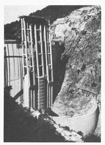
Bild 4. Dreifacher Turm für Wasserfassungen und Grundablass im Aufbau. Vorne Baugrubenabschluss
