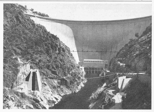
Bild 9. Anordnung der beidseitigen Ausläufe, deren Strahlen sich in spitzem Winkel in Tal-Axe treffen
