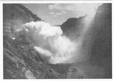
Bild 6. Probelauf zu Bild 3 mit 230 m $^3/\mathrm{s}$  (Vollast 1100 m $^3/\mathrm{s})$ zwecks Prüfung der zerstäubenden Wirkung der Anordnung
