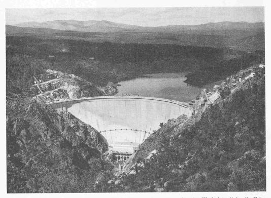
Bild 1. Ansicht des Kraftwerkes Cabril im März 1954. Am Berghang rechts der Werkplatz, links die Fahrbahnen von oben drei, unten einem Kabelkran. Stausee auf Kote 250 (Normalstau 294)
