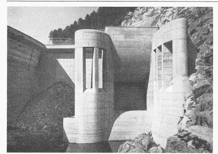
Bild 2. Einlauf zum Hochwasser-Ueberlauf rechts
