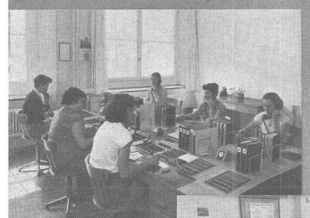
Schnurlose Vermittlungseinrichtung für Tasten-Bedienung in einer Grossbank.
