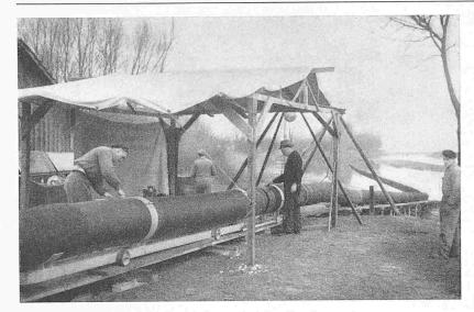
Bild 1. Die einzelnen Teilstücke werden zusammengesetzt und vulkanisiert. Die Leitung schwimmt auf dem Wasser des Alten Rheins
