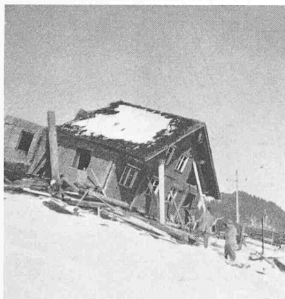
Bild 5. Haus in Sonntag. Links: nach vorn gekippter und verschobener vorderer Gebäudeteil; in der Mitte: Teil der Seitenwand des hinteren Gebäudeteils mit gehobenen und heruntergeworfenen Balken. Der Balken über dem Fenster ist ebenfalls gehoben; rechts: Einzelheit der hinteren Ecke mit ausgehobenen Zapfen
