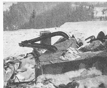
Bild 8a. Durch Lawine abgeogener Eisenständer
