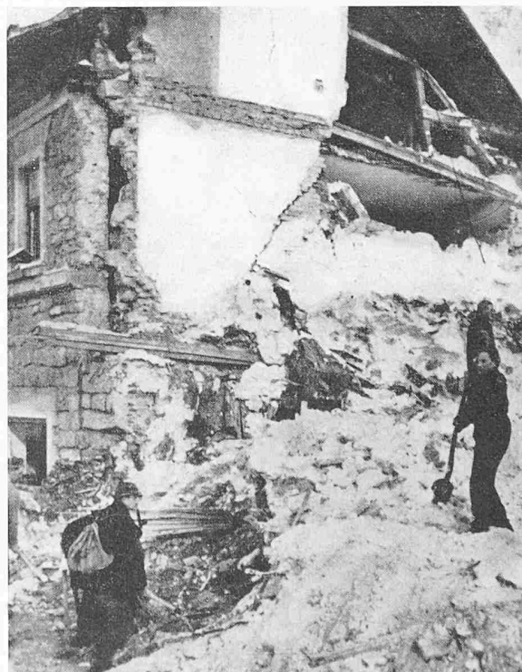
Bild 14. Zustand der Querwand des ersten Stockwerks, Lawinenrichtung von rechts nach links
