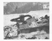
Bild 8a. Durch Lawine abgebogener Eisenständer
