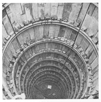
Blick in einen Rundschacht,  $\phi$  2,50 m, während des Belastungsversuches in 15 m Tiefe
