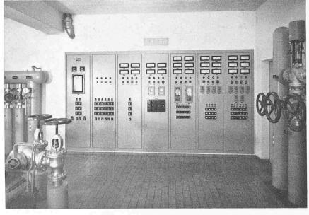
Elektrische Schaltanlage für die Wärmeversorgung
