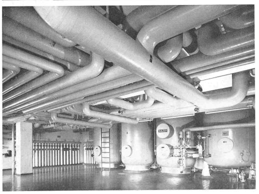
Rohrraum unter dem Pumpen- und Apparateraum, drei Warmwasserspeicher und ein Kondensatspeicher sionierte in die Werkstatt. Gegenüber dem früheren Betrieb in einem abgelegenen Lokal ist insofern ein Unterschied feststellbar, als die Leute jetzt gleich nach Arbeitsschluss kommen und dafür abends zwischen 21 und 22 h wieder gehen. Die durchschnittliche Benützerzahl pro Monat beträgt 308. Pro Monat wird im Durchschnitt für 1500 Fr. Holz verkauft.
