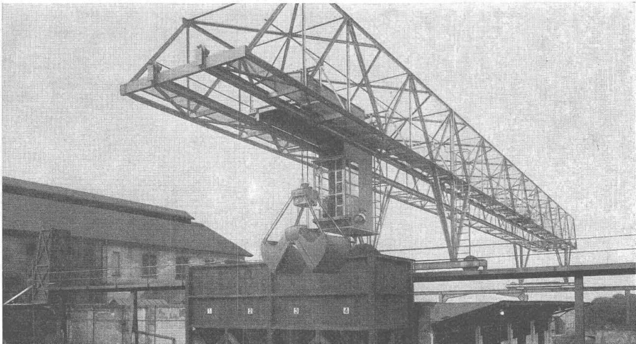
Verladebrücke in Schweisskonstruktion 2,5 t Tragkraft, 46 m Länge
