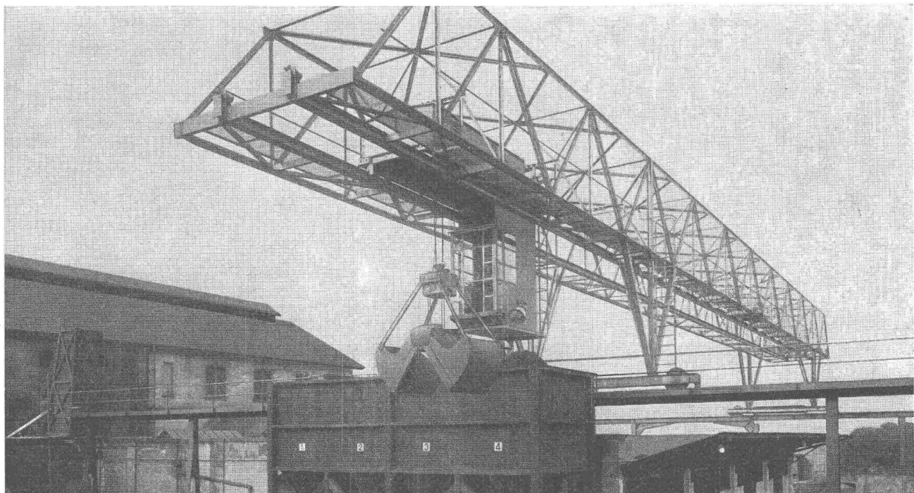
Verladebrücke in Schweisskonstruktion 2,5 t Tragkraft, 46 m Länge
