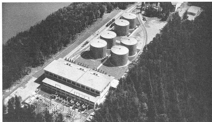
Bild 16. Gasturbinen-Kraftwerk Beznau. Vorn die Freiluftanlage mit Transformatoren, dahinter die Zentrale mit den 16 Kaminen, anschliessend 6 Brennstofftanks mit Gleisanschluss, links die Aare
