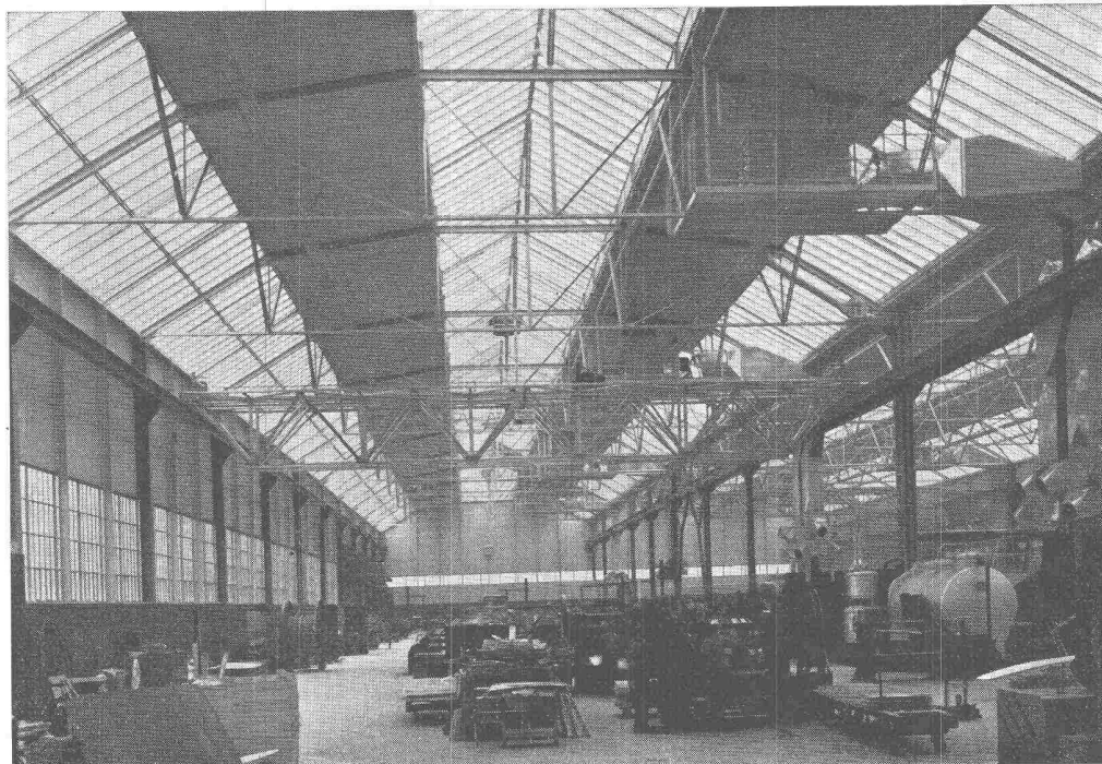
Produktionshalle, Krangerüst in Leichtmetall
