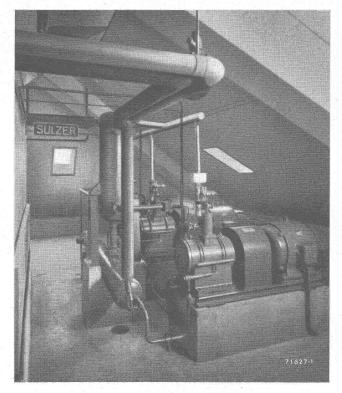
Kühlmaschinen für eine grössere Luftkonditionierungsanlage
