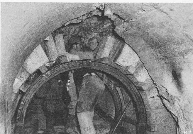
Fig. 14. Revêtement de granit en cours d'exécution (on distingue les briques éclatées du premier revêtement de béton)
