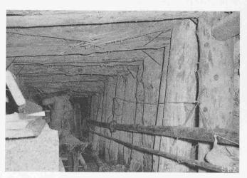
Fig. 4. Au  $1^{\rm er}$  plan en haut, un chapeau brisé. Au radier, les pointelles sont repoussées vers le centre
