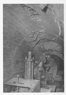
Fig. 9. Fissuration et éclatement du revêtement de béton. Armatures  $\phi$  30 cm tordues
