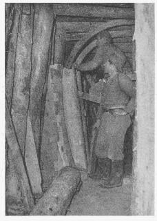
Fig. 8. Bétonnage d'un pied-droit du 1<sup>er</sup> revêtement en béton (comp. fig. 5)
