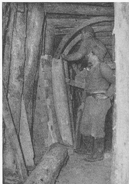
Fig. 8. Bétonnage d'un pied-droit du 1er revêtement en béton (comp. fig. 5)
