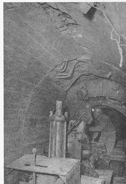
Fig. 9. Fissuration et éclatement du revêtement de béton. Armatures Ø 30 cm tordues
