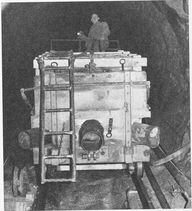
Bild 6. Kiestransportwagen (Inhalt 2 m 3 Kies) mit den Entleerungsstutzen
