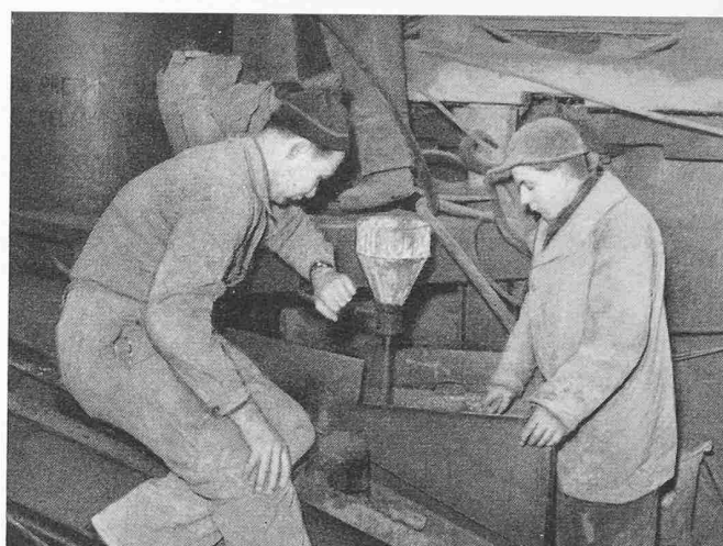
Bild 10. Ausflussversuch aus dem Flow-Cone zur Bestimmung der Konsistenz (Wasserkontrolle) des Prepaht-Mörtels
