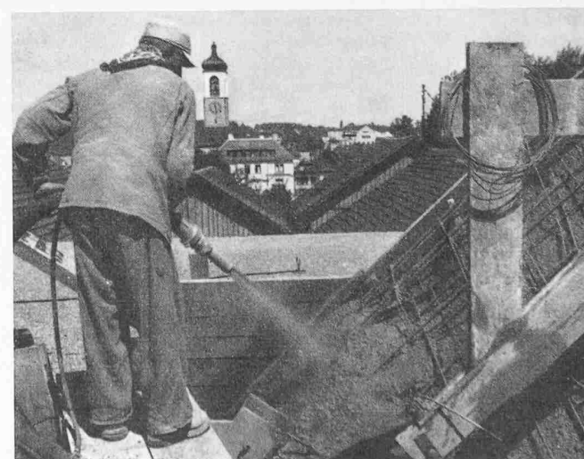
Bild 8. Betonieren nach dem Spritzverfahren der «Stribag», Zürich
