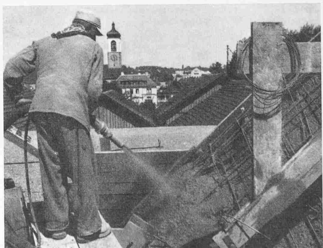
Bild 8. Betonieren nach dem Spritzverfahren der «Spribag», Zürich
