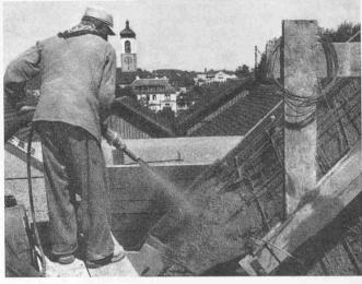
Bild 8. Betonieren nach dem Spritzverfahren der «Spribag», Zürich
