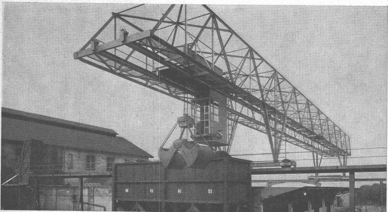
Verladebrücke in Schweisskonstruktion 2,5 t Tragkraft, 46 m Länge
