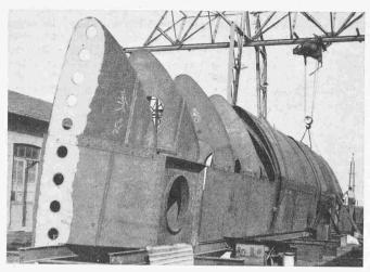
Bild 2. Montage des Hauptträgerkastens vor der Werkhalle in Battaglia
