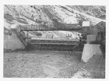
Bild 1. Hydraulisch-automatische Segmentschütze in Pescara. Fachwerkkonstruktion
