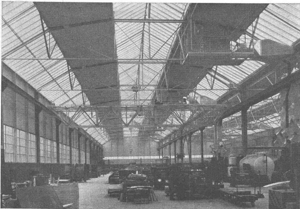
Produktionshalle, Krangerüst in Leichtmetall
