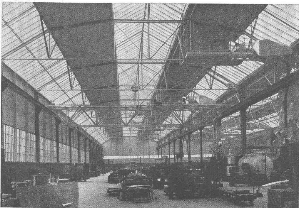
Produktionshalle, Krangerüst in Leichtmetall
