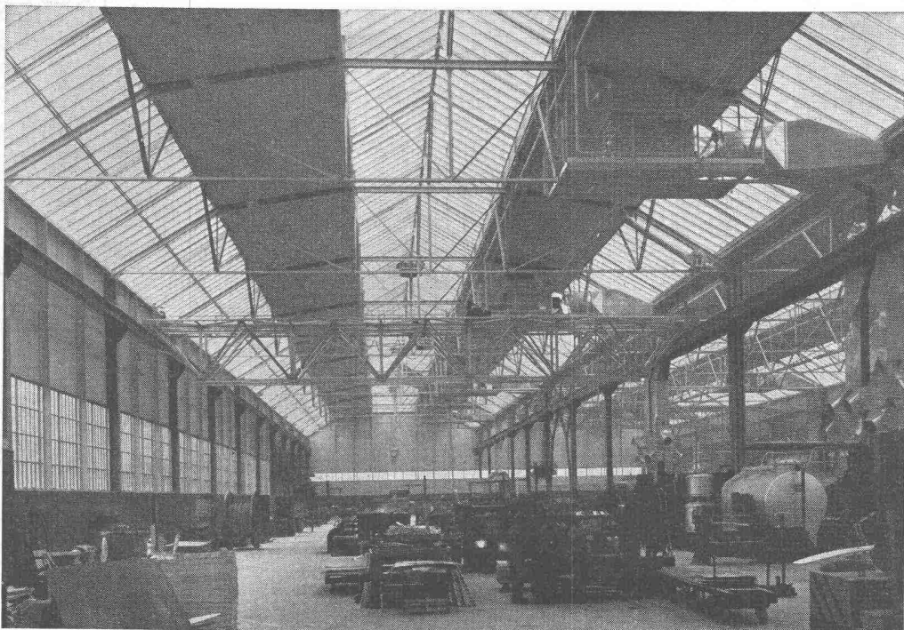
Produktionshalle, Krangerüst in Leichtmetall
