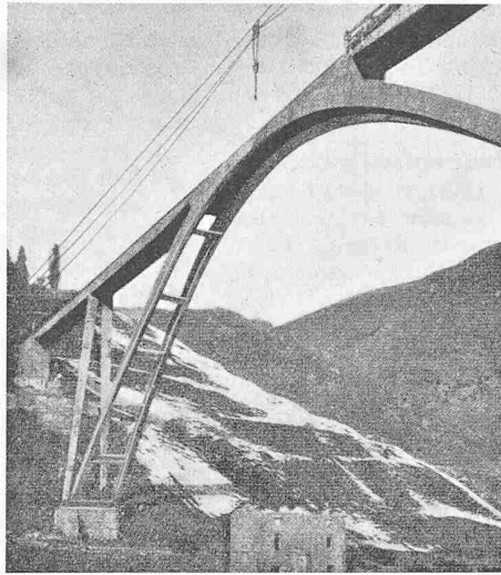
Bild 1. Eisenbetonsteg von Vagli di Sotto
