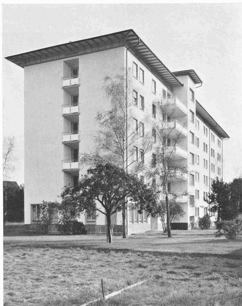
Ansicht des Schwesternhauses von Norden (Aufnahme vom 2. Oktober 1950)
