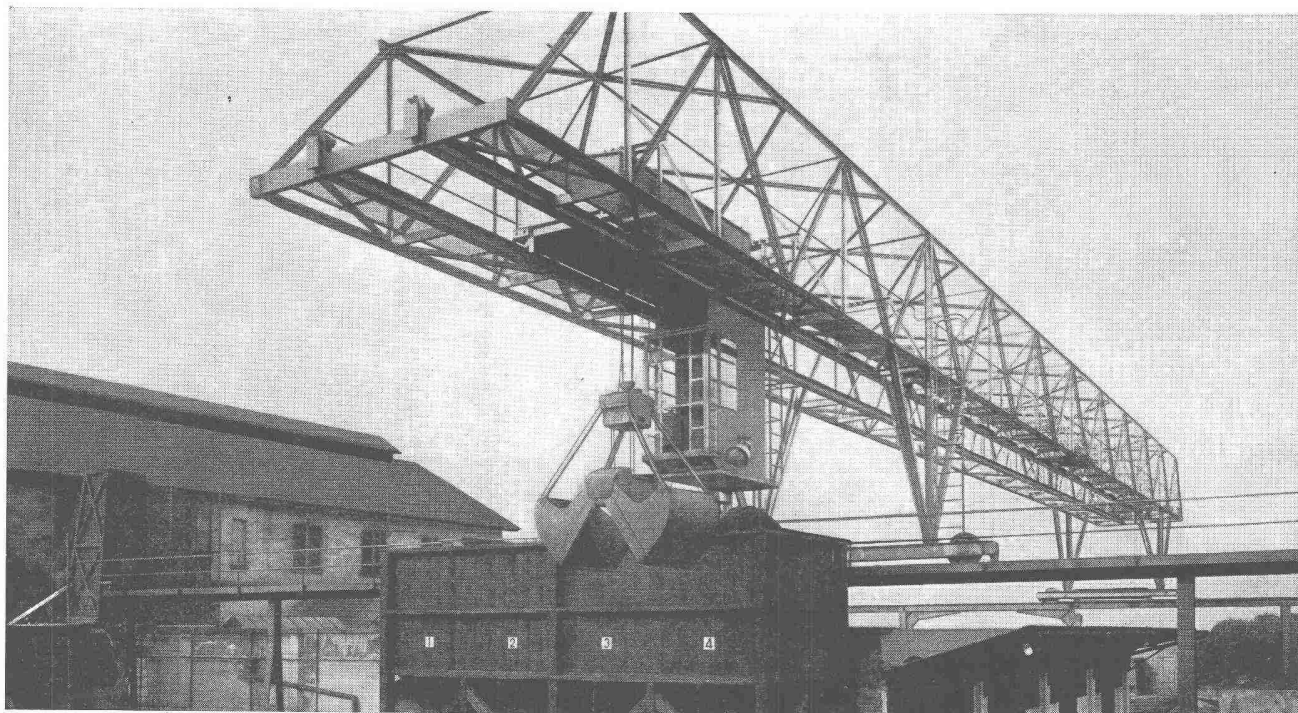
Verladebrücke in Schweisskonstruktion 2,5 t Tragkraft, 46 m Länge
