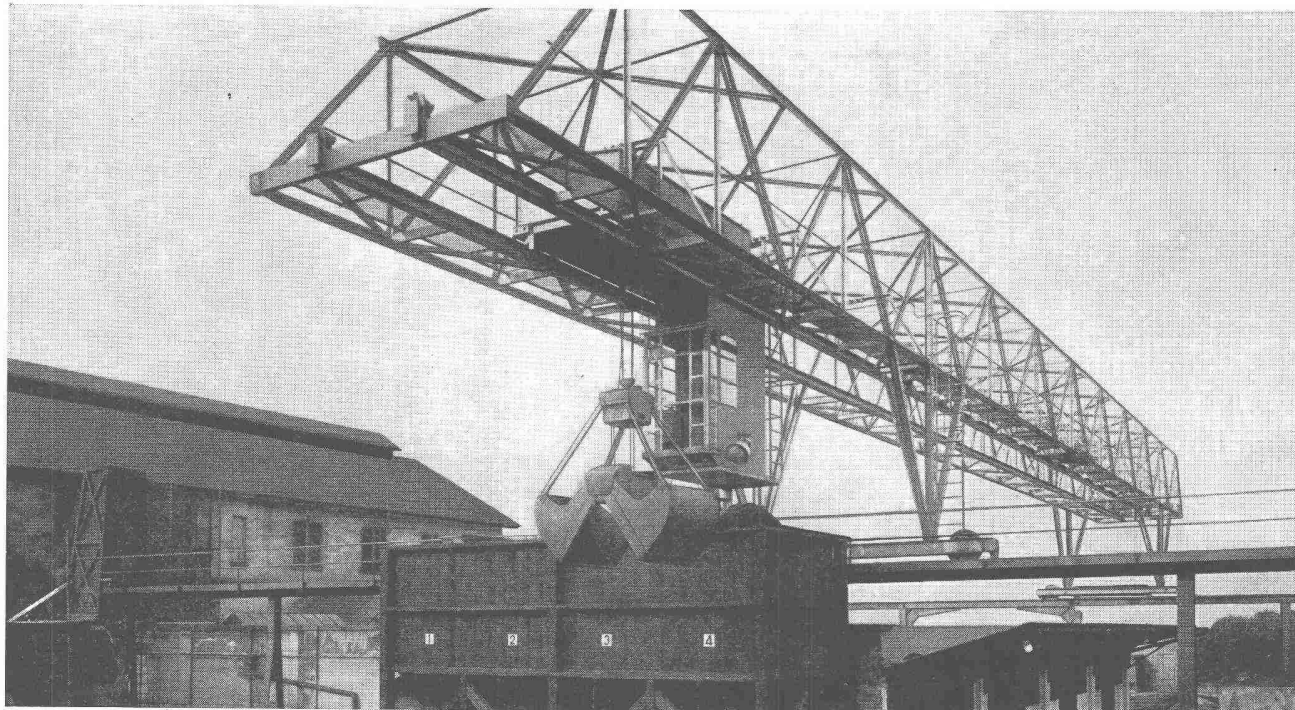
Verladebrücke in Schweisskonstruktion 2,5 t Tragkraft, 46 m Länge
