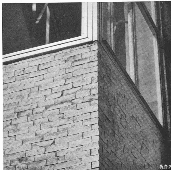
Bild 30. Fassadenverkleidung aus Tesserini di marmo Carrara, Schichthöhe 3 cm
