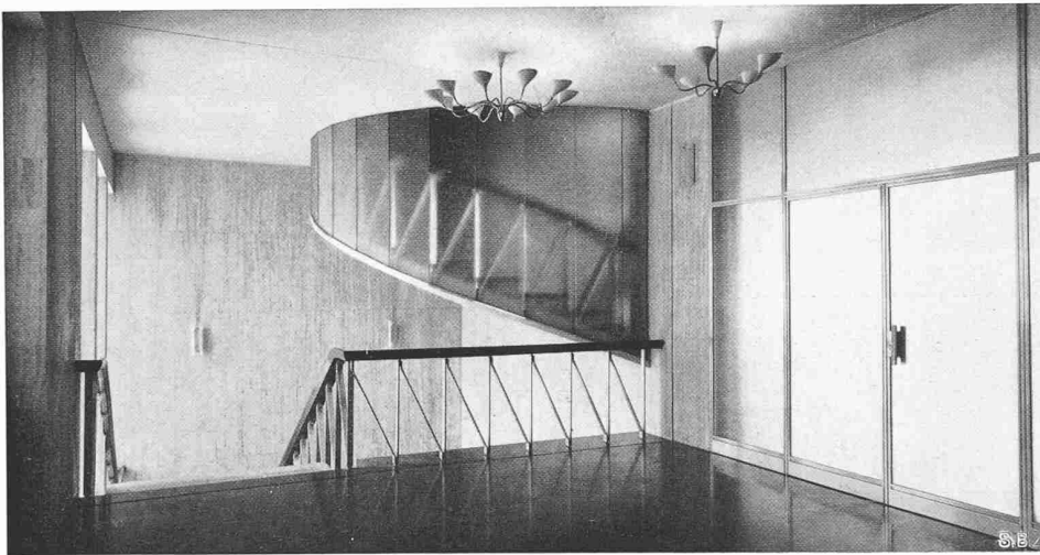
Bild 25. Treppenvorplatz im dritten Geschoss, verglaste Wendeltreppe in den vierten Stock (zur Bar)
