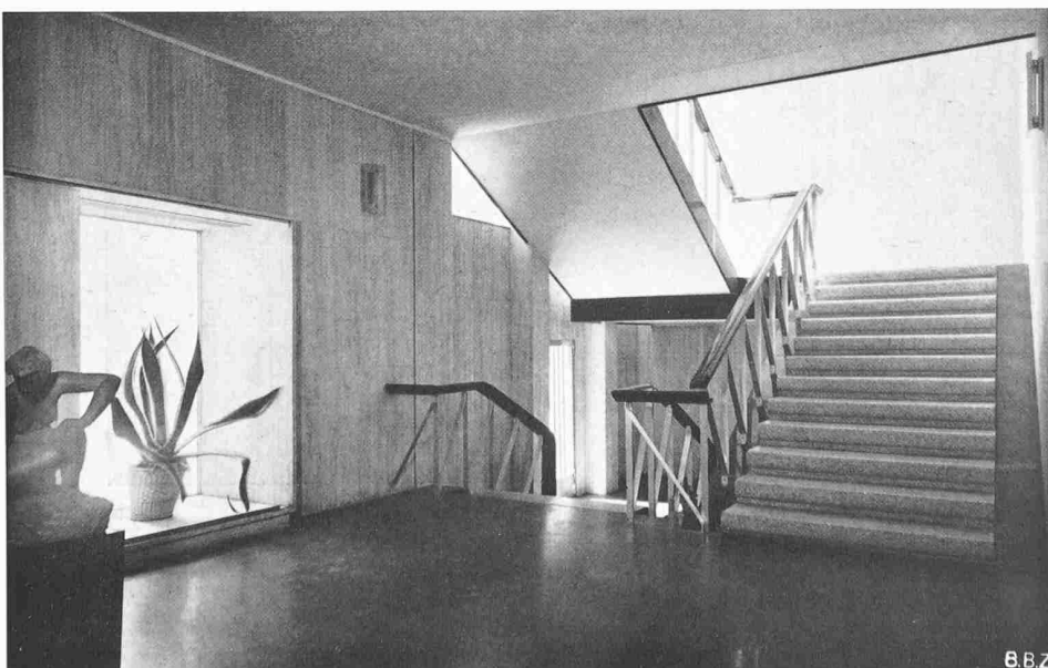
Bild 26. Antritt der Haupttreppe in der Halle des Vorderhauses, Wangen und Boden schwarzer Marmor, Stufen ge- schliffener heller Granit
