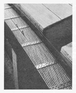
Bild 4. Spannglied, bestehend aus mehreren Lagen gut geordneter Litzen aus Stahl 180, mit Abstandhalter im rechteckigen Blechkasten vor dem Schliessen
