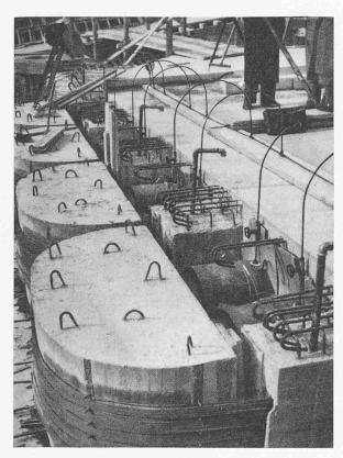
blöcke infolge der Pressewirkung gedehnt; sie werden gespannt und das Tragwerk wird unter Druck gesetzt. Die grundsätzliche Anordnung ist durch Bild 1 im Längsschnitt und Bild 2 im Grundriss veranschaulicht.
