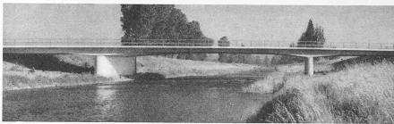
V = 3500 t mit elf Spannblöcken. Entwurf: Ingenieurbureau Dr. Leonhardt, Stuttgart, Ausführung: F. X. Sichler & Co., Freiburg i. Br.
