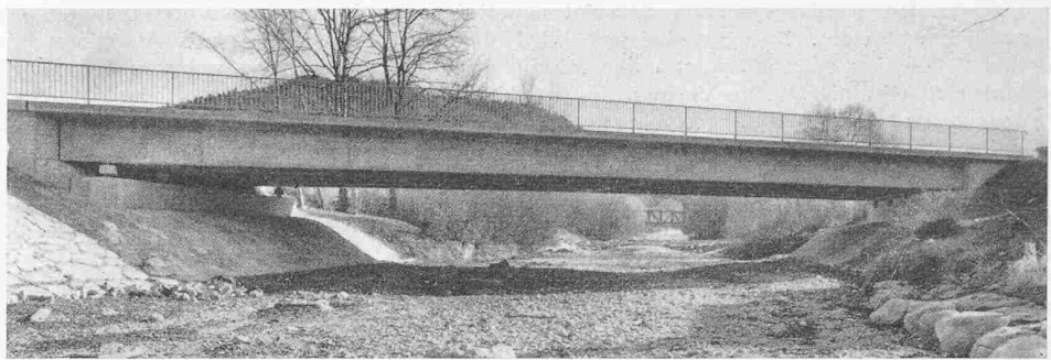
Bilder 17 und 18. Tössbrücke Wila (Kt. Zürich) 1952. Plattenbalkenbrücke (Schiefe: \alpha = 60^\circ ) mit fünf Trägern in einer Oeffnung l = 29,6 m, konstante Bauhöhe d = 114 cm, d/l = 26 . Spannkraft V = 2910 t mit vier Spannblöcken. Beschränkte Quervorspannung mit Spannglieder 12 \times 5 \phi , V = 24 t des Systemes BBRV. Entwurf: Ingenieurbureau E. Schubiger, Zürich. Ausführung: Locher & Co. und Stahlton AG., Zürich.
