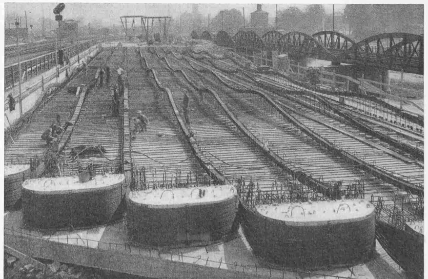
Bild 5. Gesamtansicht der verlegten Spannglieder der Eisenbahnbrücke über den Neckarkanal in Heilbronn. Erster Bauabschnitt des schiefen Bauwerkes durchlaufend über fünf Öffnungen mit sieben Spannblöcken. Links sind die Spannglieder fertig, in der Mitte werden die Blechkasten geschlossen, rechts werden die Litzen verlegt. (vgl. auch Bilder 7 und 10)
