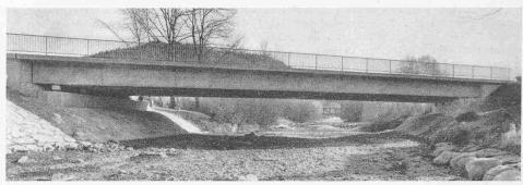
schränkte Quervorspannung mit Spannglieder  $12 \times 5 \phi$ , V = 24t des Systemes BBRV. Entwurf: Ingenieurbureau E. Schubiger, Zürich. Ausführung: Locher & Co. umd Stahlton AG., Zürich.
