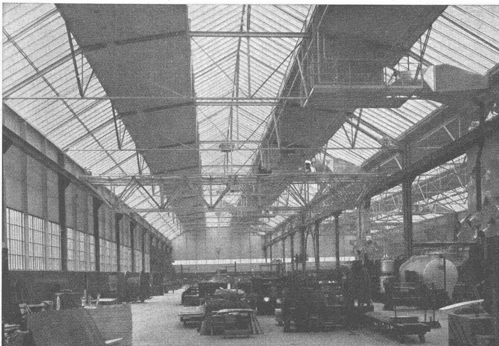
Produktionshalle, Krangerüst in Leichtmetall
