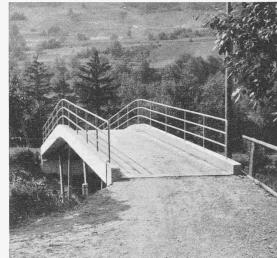
Bilder 4 und 5. Die Brücke von 1954: Stahlkonstruktion mit Fahrbahnplatte aus Eisenbeton
