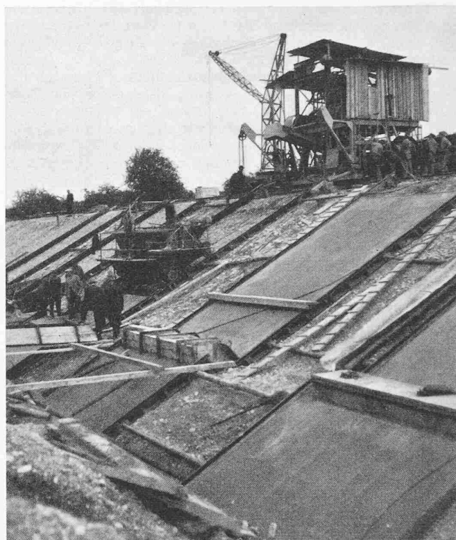
Bild 86. Betonieren einer Dammböschung im Staugebiet
