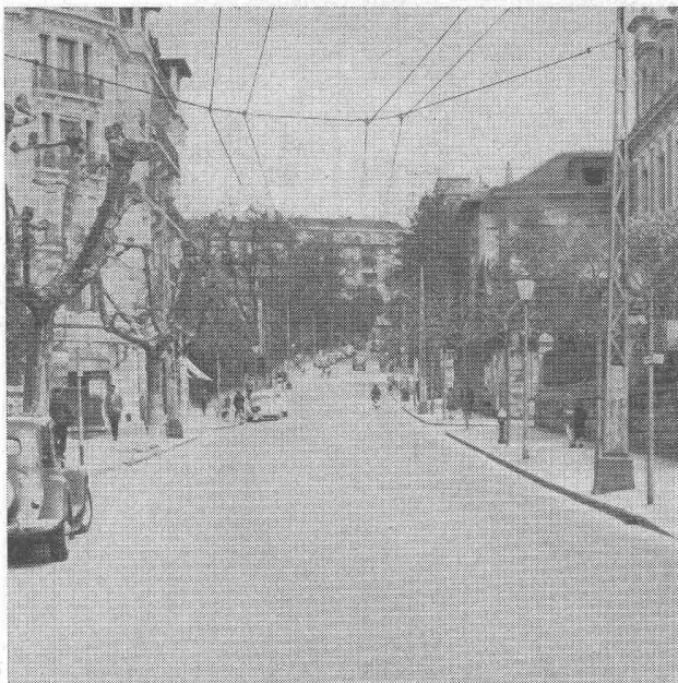
Lausanne, avenue d'Ouchy CARPAVE-Belag erstellt 1938
