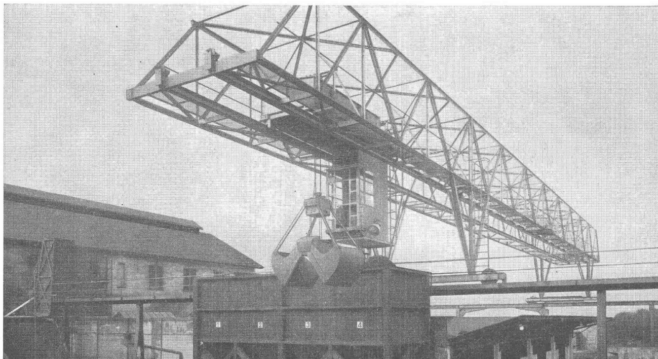
Verladebrücke in Schweisskonstruktion 2,5 t Tragkraft, 46 m Länge
