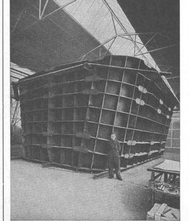
CUVE EXTÉRIEURE DE FOUR ÉLECTRIQUE POIDS 100 TONNES
