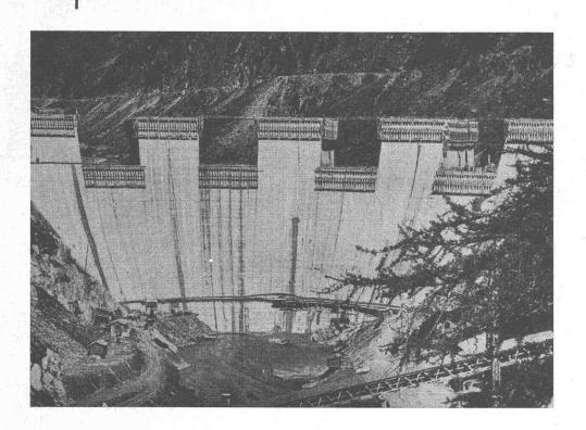
Beim Bau der Staumauer Sambuco der Maggia-Kraftwerke AG wird für den Vorsatzbeton FRIOPLAST als Betonzusatz verwendet.
