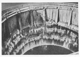
Verschluss einer Wehröffnung des Kraftwerkes Mariborski an der Drau durch Horizontalgewölbe aus Beton mit aufgesetztem Nadelwehr aus Holz
