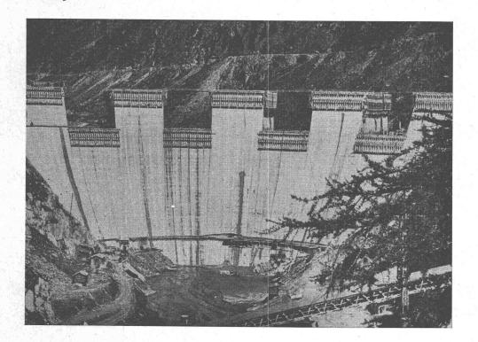
Beim Bau der Staumauer Sambuco der Maggia-Kraftwerke AG wird für den Vorsatzbeton FRIOPLAST als Betonzusatz verwendet.
