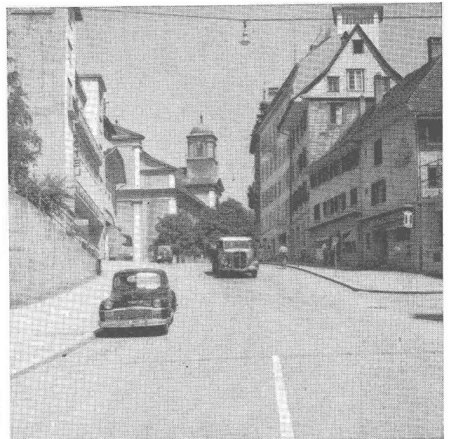
Mühlegasse Olten, Steilrampe mit Bitumen-Rauhbelag
