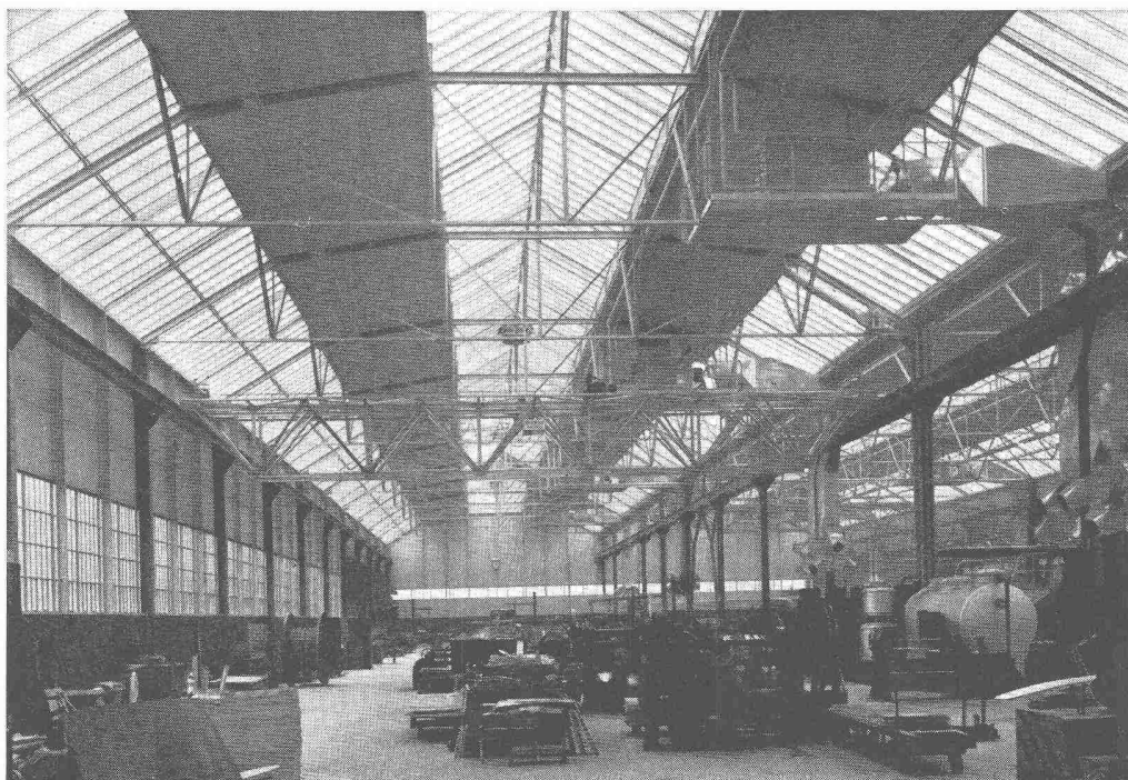
Produktionshalle, Krangerüst in Leichtmetall
