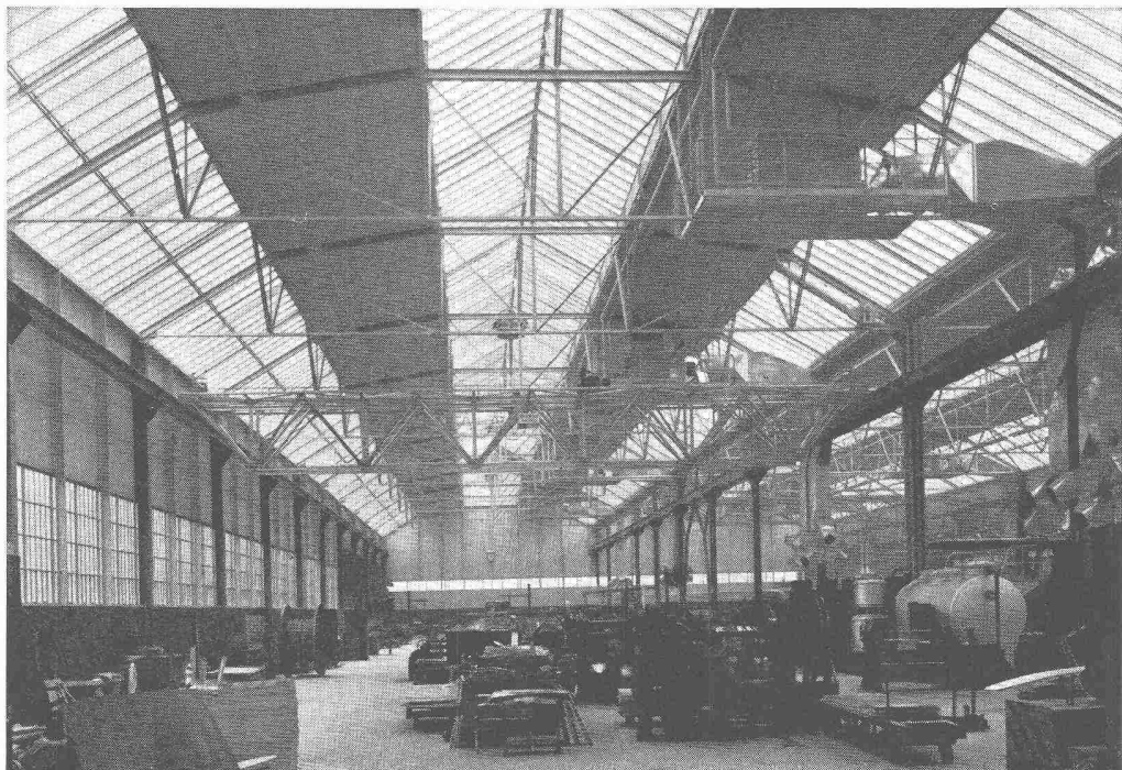
Produktionshalle, Krangerüst in Leichtmetall
