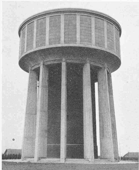
Fig. 8. Réservoir de Jussy. La cuve a un diamètre extérieur de 16,84 m et sa partie la plus haute se trouve à 24,42 m au-dessus du sol
