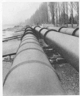
Fig. 12. Pose d'un tronçon de la conduite sous-lacustre de 1600 mm de diamètre (voir plan fig. 14)
