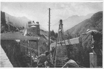
Bild 6. Versetzen eines Unterzuges
