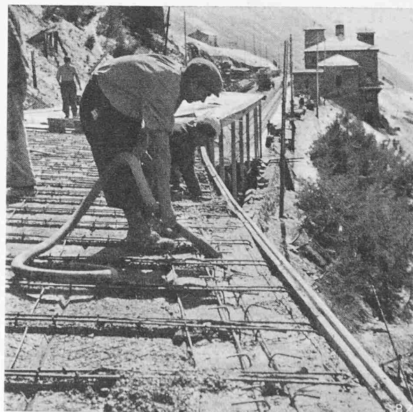
Bild 9. Betonierung des Troges über den Unterzügen
