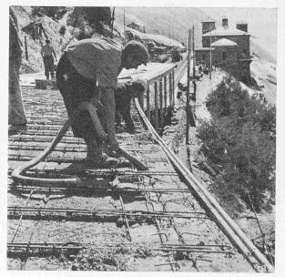
Bild 9. Betonierung des Troges über den Unterzügen
