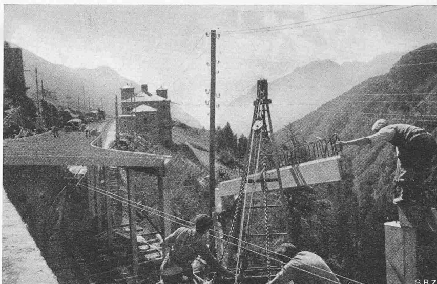
Bild 6. Versetzen eines Unterzuges
