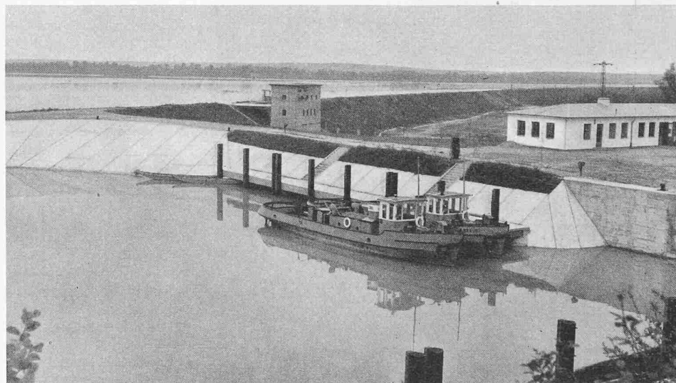
Bild 63. Pumpwerk und Hafen Seibersdorf
