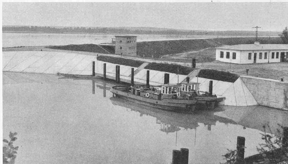
Bild 63. Pumpwerk und Hafen Seibersdorf
