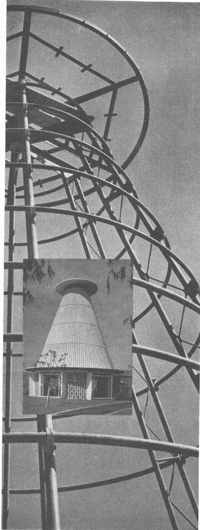
Tee pavillon des Strandbades Tiefenbrunnen, Stahlskelett und fertiges Bauwerk
