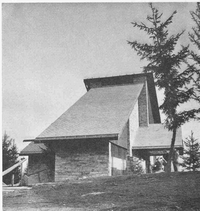
Fig. 12. Vista da nord-ovest
