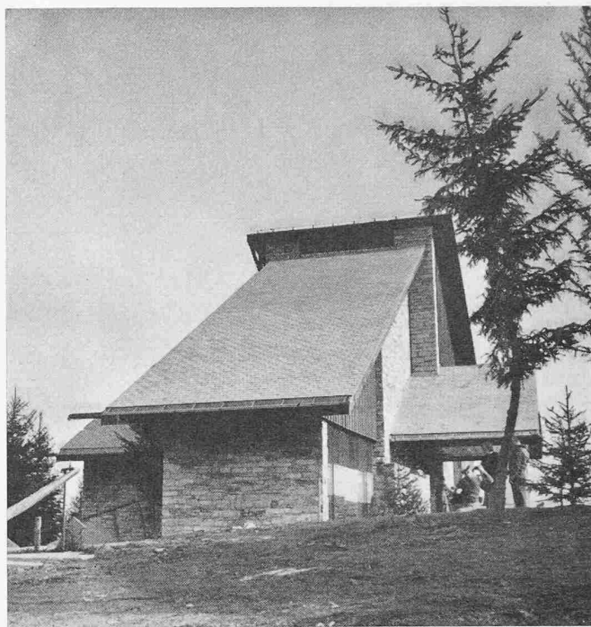
Fig. 12. Vista da nord-ovest
