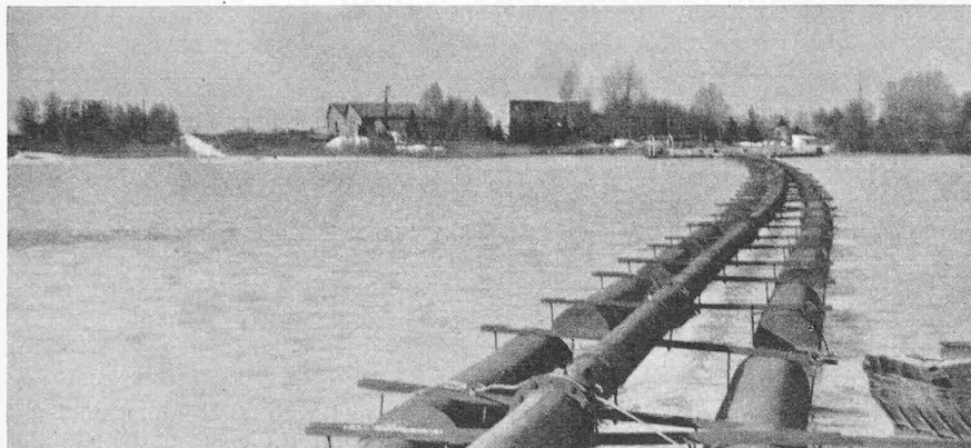
Bild 3. Gewinnung aus dem Grundwasser mit Saugbagger
