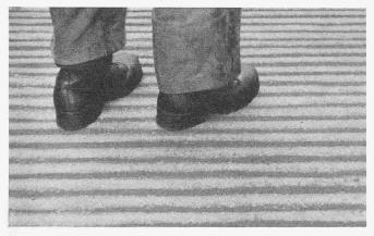
Bild 18. Betonböden und Pisten sollen nicht glatt abgerieben, sondern quer zur Fahrrichtung leicht gewellt werden (Wellenlänge 50 mm, Wellentiefe 5 mm). Der anfallende Formsand sammelt sich im Wellental, wo er leicht feucht gehalten werden kann
