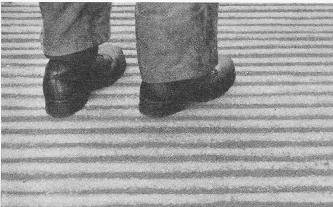
Bild 18. Betonböden und Pisten sollen nicht glatt abgerieben, sondern quer zur Fahrriechtung leicht gewellt werden (Wellenlänge 50 mm, Wellentiefe 5 mm). Der anfallende Formsand sammelt sich im Wellental, wo er leicht feucht gehalten werden kann
