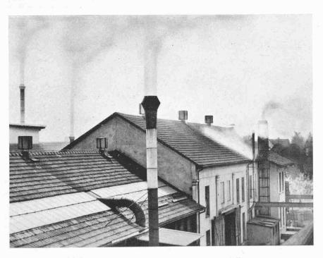
Bild 16. Die Anordnung der 3 Exhaustoren links ist richtig. Die Abluft (durch Rauchentwicklung sichtbar gemacht) strömt unbehindert in die freie Atmosphäre, wo der Feinstaub rasch verdünnt und unschädlich wird. Die Anordnung des kleinen Exhaustoren rechts, mit dem früher üblichen Regendach, ist falsch. Der Feinstaub wird auf das Dach und die nähere Umgebung niedergeschlagen.
