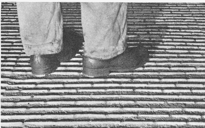
Bild 19. Auch die vor den Putzhäusern übliche Boden-Konstruktion, bestehend aus Platten in Grau- oder Stahlguss, sollen mit Rippen versehen werden. Diese Konstruktion schützt zusätzlich vor dem Ausgleiten auf dem Stahlkies
