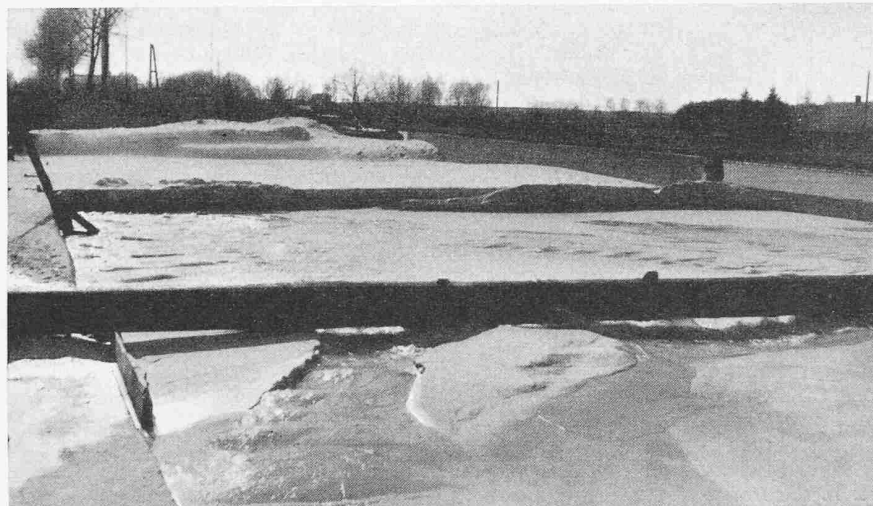
Bild 4. Transport durch Druckwasser in Beton-Silos
