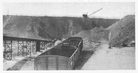
Bild 2. Grube Jemepp bei Charleroi. Quarzsand mit r<br/>d. 80 % Si $\rm O_2$ und 20 % Ton, Schichthöhe etwa 25 m
