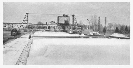
Bild 5. Verlad mittelst fahrbarer Brücke, Bagger und Transportband auf Kanalschiffe und Eisenbahnwagen.
