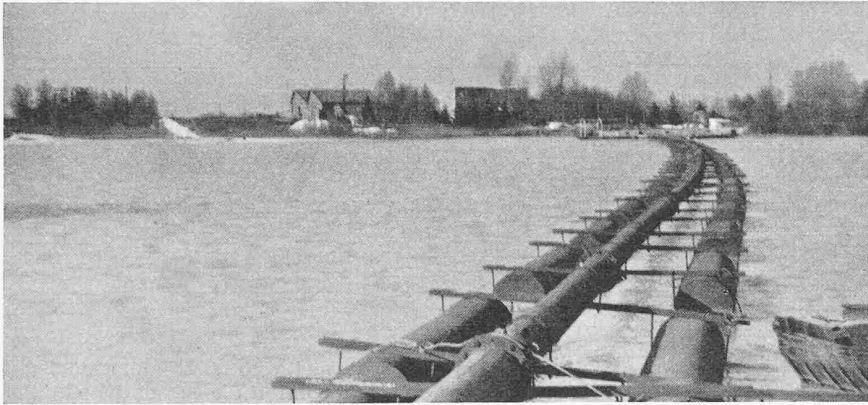
Bild 3. Gewinnung aus dem Grundwasser mit Saugbagger
