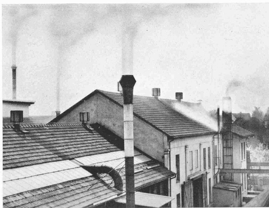
Bild 16. Die Anordnung der 3 Exhaustoren links ist richtig. Die Abluft (durch Rauchentwicklung sichtbar gemacht) strömt unbehindert in die freie Atmosphäre, wo der Feinstaub rasch verdünnt und unschädlich wird. Die Anordnung des kleinen Exhaustoren rechts, mit dem früher üblichen Regendach, ist falsch. Der Feinstaub wird auf das Dach und die nähere Umgebung niedergeschlagen.
