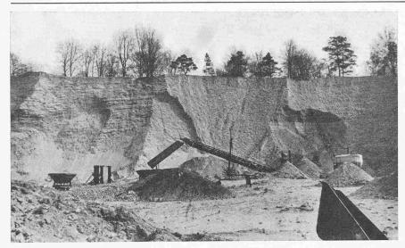
Bild 1. Grube Tilly bei Watterloo. Quarzsand mit rd. 96 % SiO $_2$ , Schichthöhe rd. 15 m
