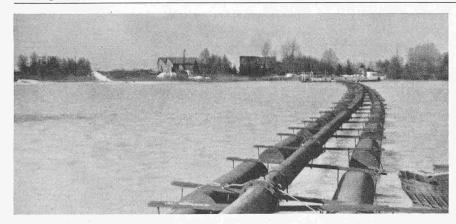
Bild 3. Gewinnung aus dem Grundwasser mit Saugbagger
