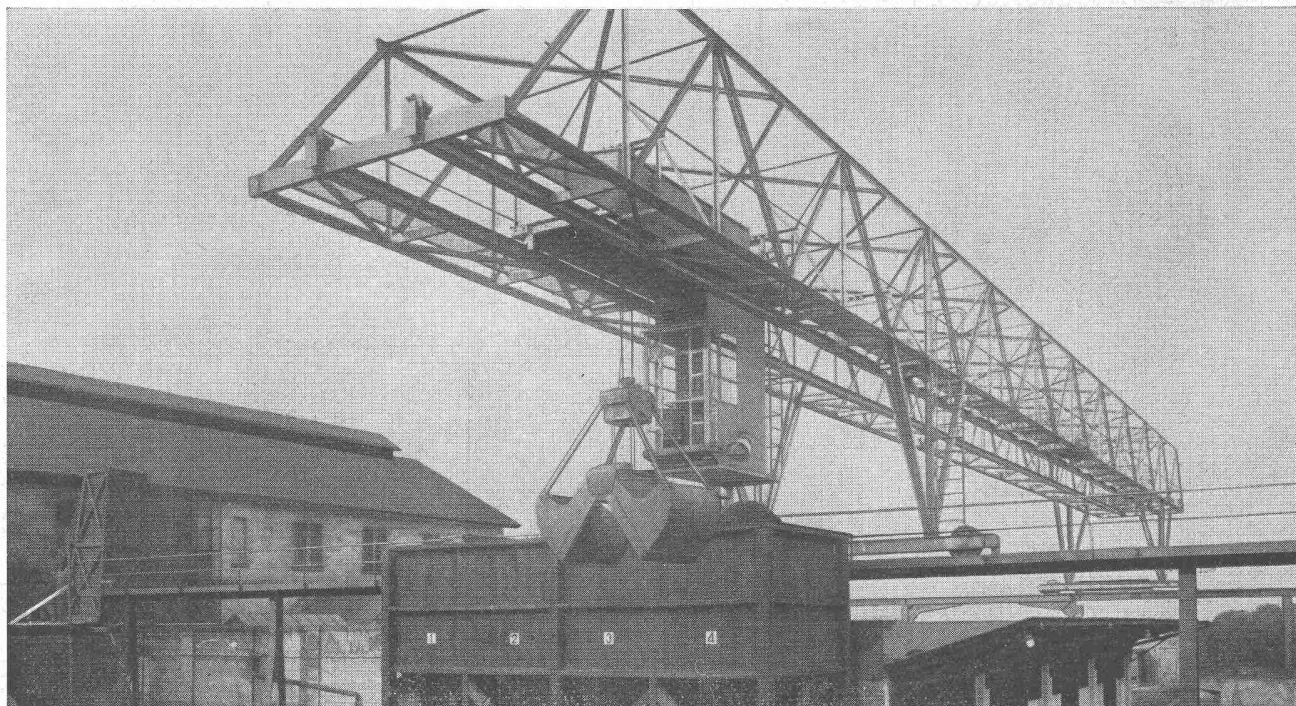
Verladebrücke in Schweisskonstruktion 2,5 t Tragkraft, 46 m Länge
