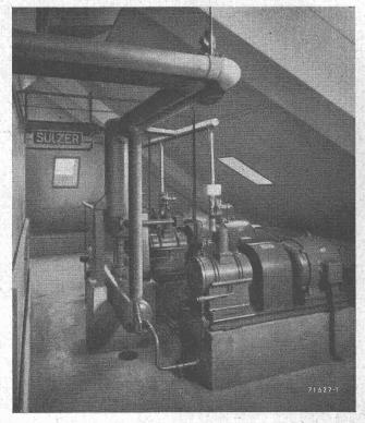
Kühlmaschinen für eine grössere Luftkonditionierungsanlage
