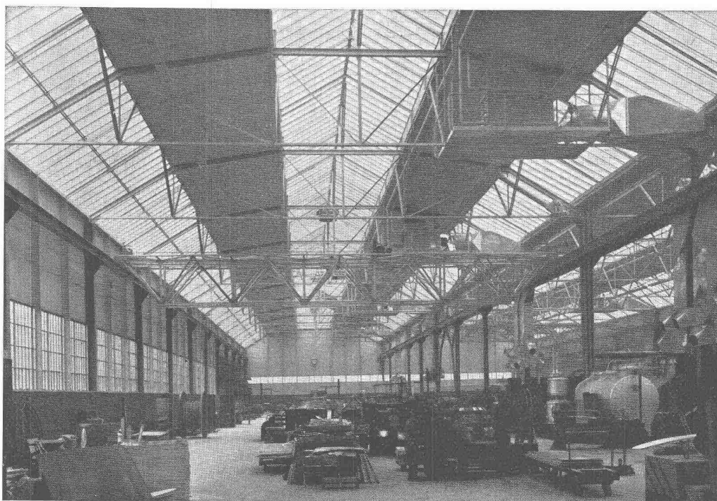
Produktionshalle, Krangerüst in Leichtmetall
