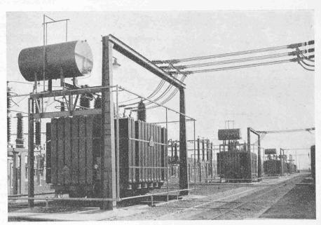
Bild 52. Blocktransformatoren in der 110 kV-Schaltanlage
