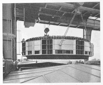
Bild 49. Einsetzen des Generatorstators
