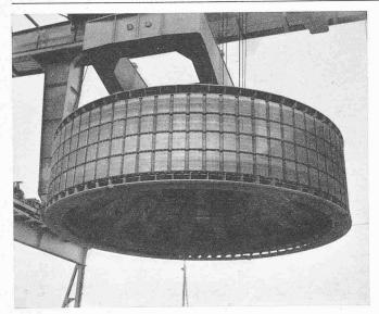
Bild 48. Läufer ohne Pole, am Kran hängend
