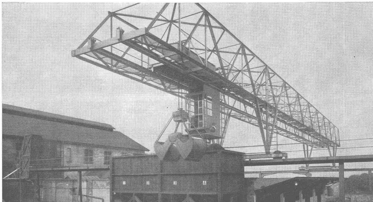
Verladebrücke in Schweisskonstruktion 2,5 t Tragkraft, 46 m Länge
