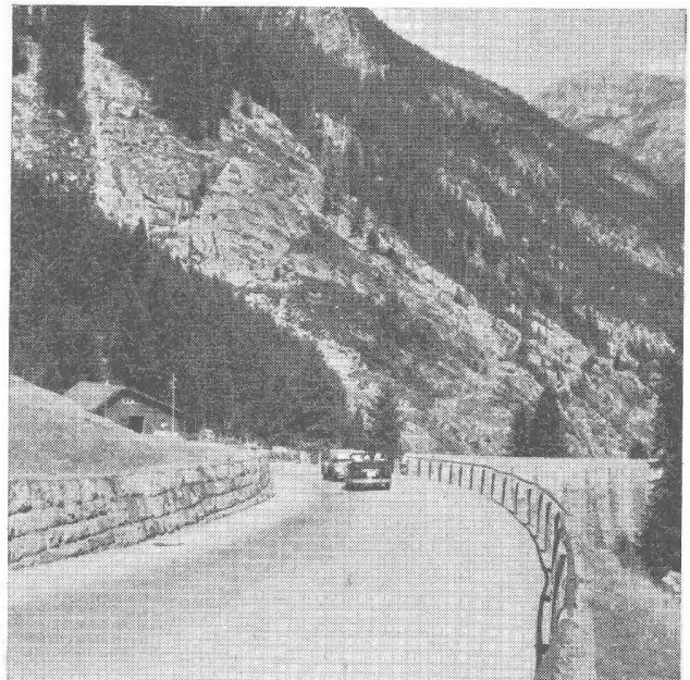
Gotthardstrasse mit CARPAVE-Belag
