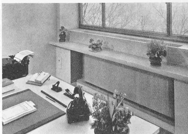
Bild 7. Einbau eines Jettair-Apparates in einem Bürauraum
