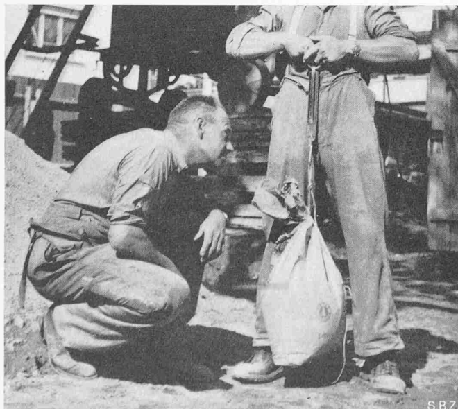
Bild 1. Wägen der Zementbeigabe mit Federwaage
