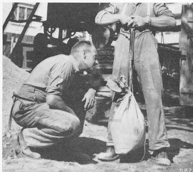
Bild 1. Wägen der Zementbeigabe mit Federwaage
