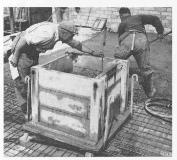
Bild 2. Messen des Abstichs in der Betonmasskiste
