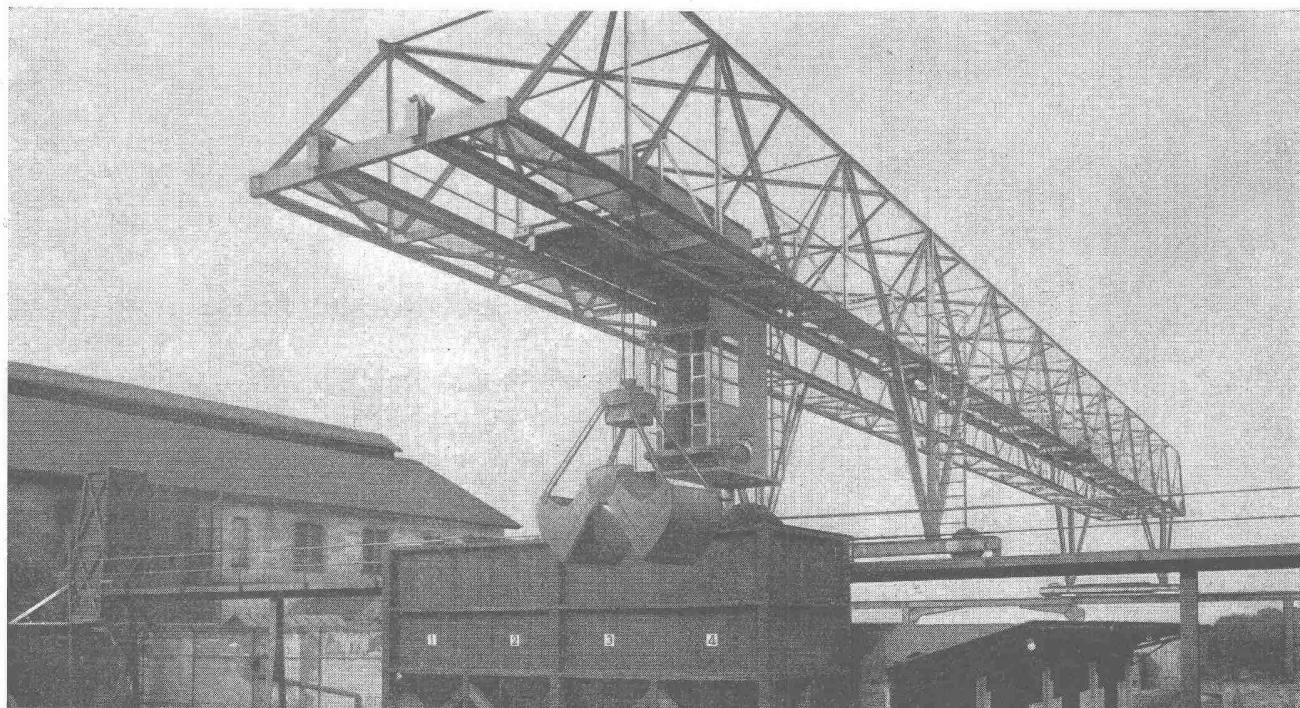
Verladebrücke in Schweisskonstruktion 2,5 t Tragkraft, 46 m Länge
