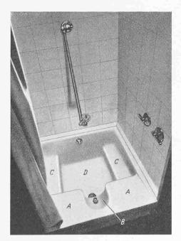
Bild 2. Normal montierte Poliban-Wanne; Legende im Text
