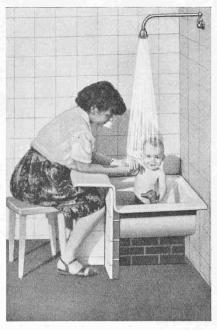
Bild 3. 55 cm hoch montierte Poliban-Wanne (Armatur unpraktisch!)
