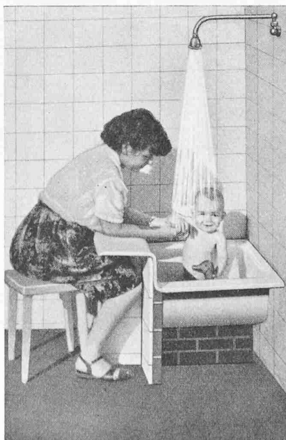
Bild 3. 55 cm hoch montierte Poliban-Wanne (Armatur unpraktisch!)
